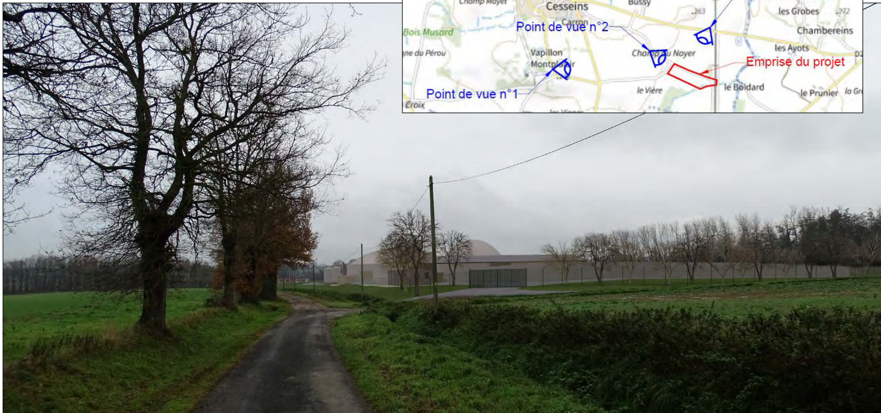
PC6.2 – Vue proche sur le projet depuis la Voie communale n°202
