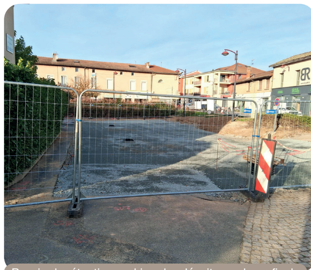
Bassin de rétention parking des Jésuites - phase finale
