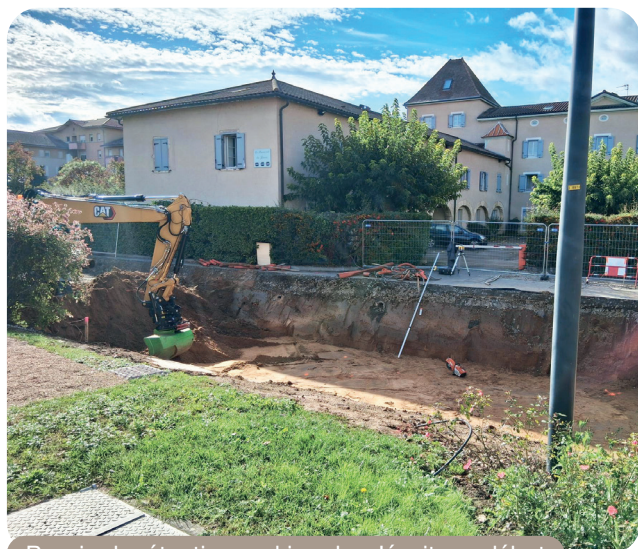
Bassin de rétention parking des Jésuites - début
