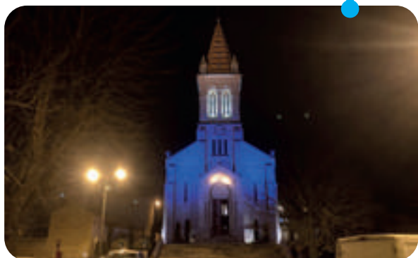
Parvis de l'Eglise et éclairage - 2022 312 600 €
