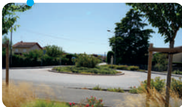
Création d'un rond-point Angle de l'Avenue Edouard Herriot et de la rue Beurivage - 2022 560 624 €
